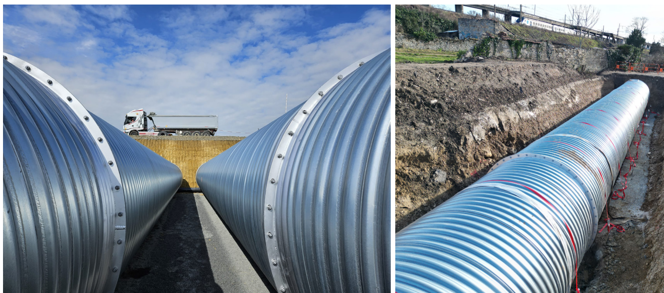
Joint EPDM étanche entre les deux brides boulonnées - pose en nappe avec lestage avec sangles sur longrines béton
