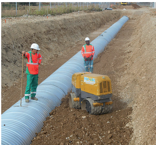
Lit de pose propre et stable
