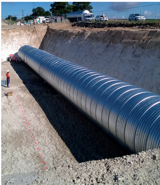
Lit de pose propre et stable
