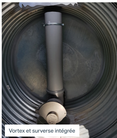
Vanne de confinement et vortex
