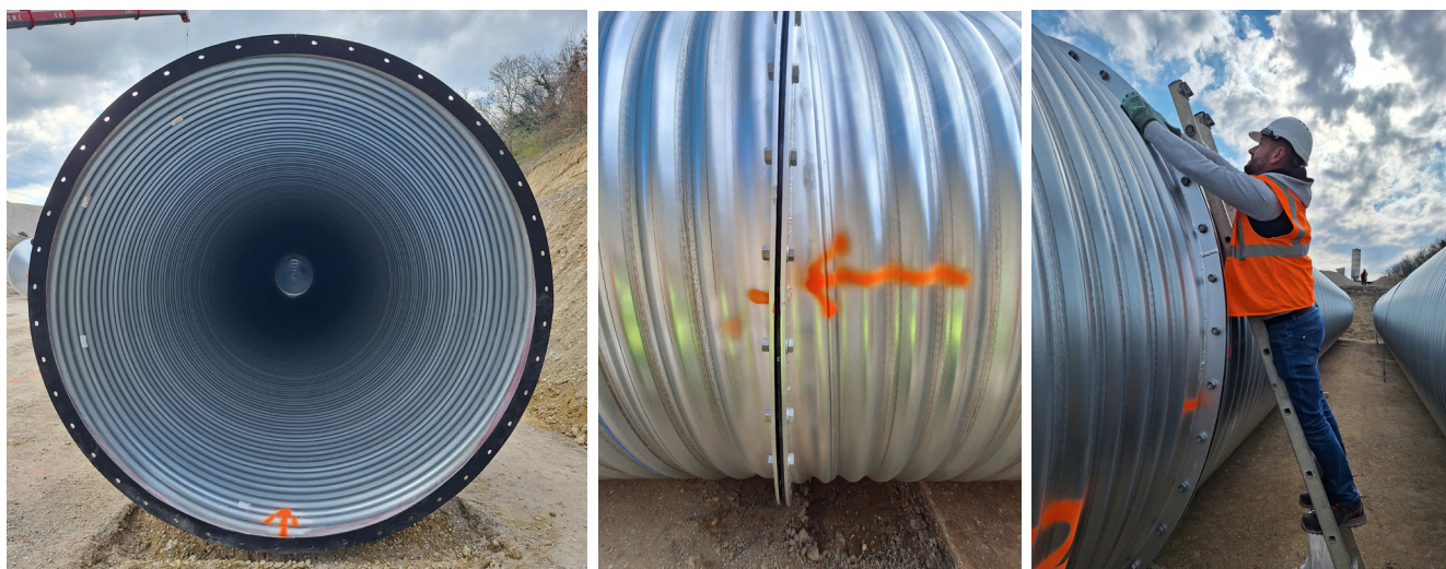
Brides soudées en usine - assemblage facile par boulonnerie M20 fournie
