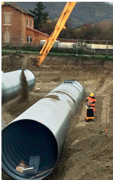
Compactage par couches symétriques de 30 cm
