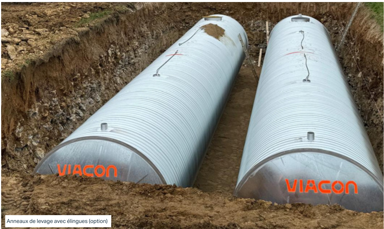
Cuves jumelées par pièces à brides
