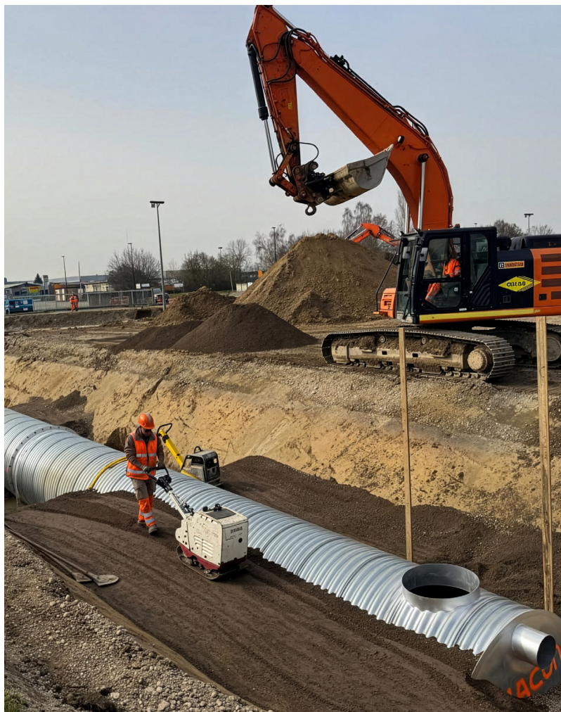
Compactage par couches symétriques de 30 cm
