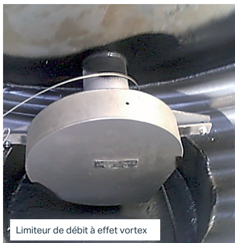
Vortex et surverse intégrée
