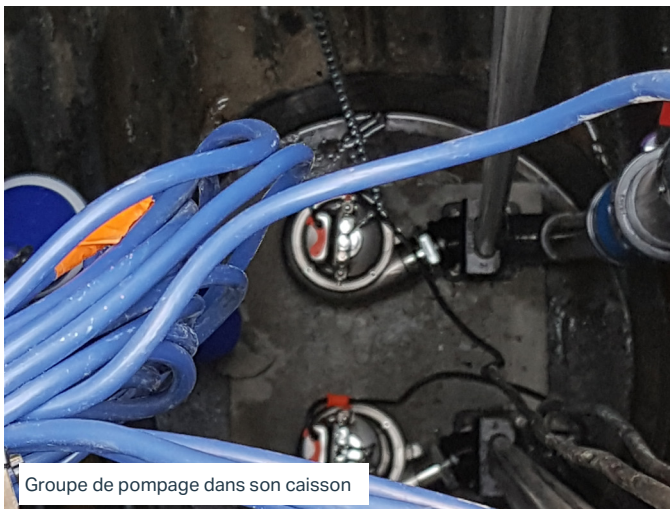
Manutention sur barre de guidage
