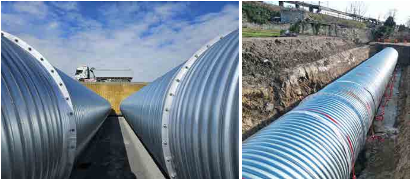
Joint EPDM étanche entre les deux brides boulonnées - pose en nappe avec lestage avec sangles sur longrines béton
