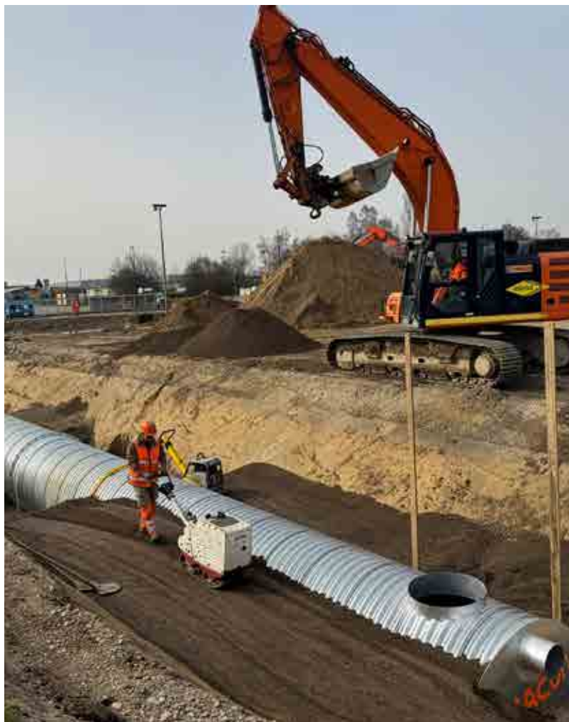
Compactage par couches symétriques de 30 cm
