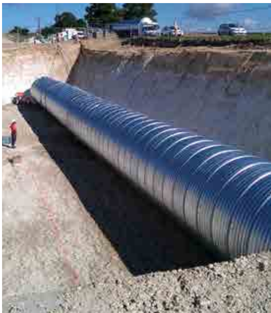
Lit de pose propre et stable
