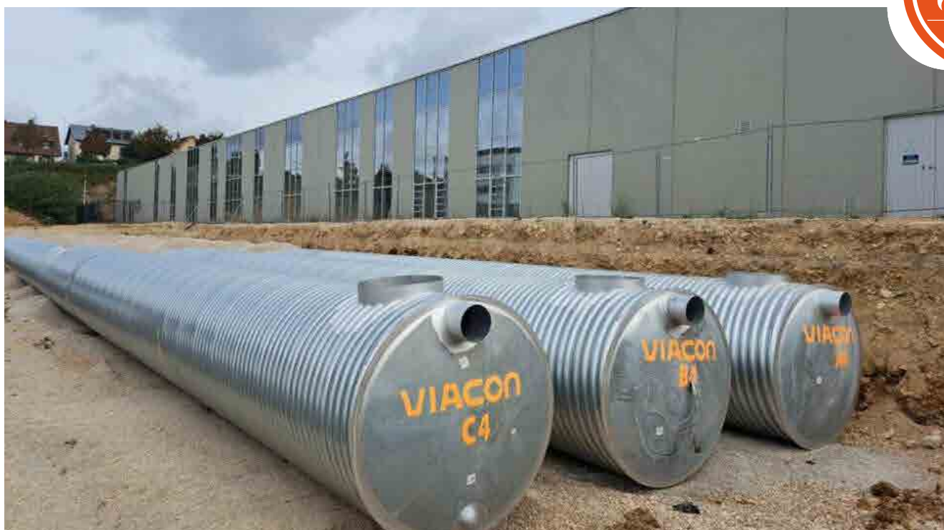
Accessoires intégrés dans l'ouvrage : gain de temps et économie Ouvrage mixte eau pluviales / D9A
