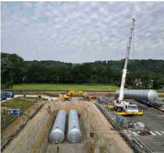
TuboSTORM® 140M 3 avec anneaux de levage
