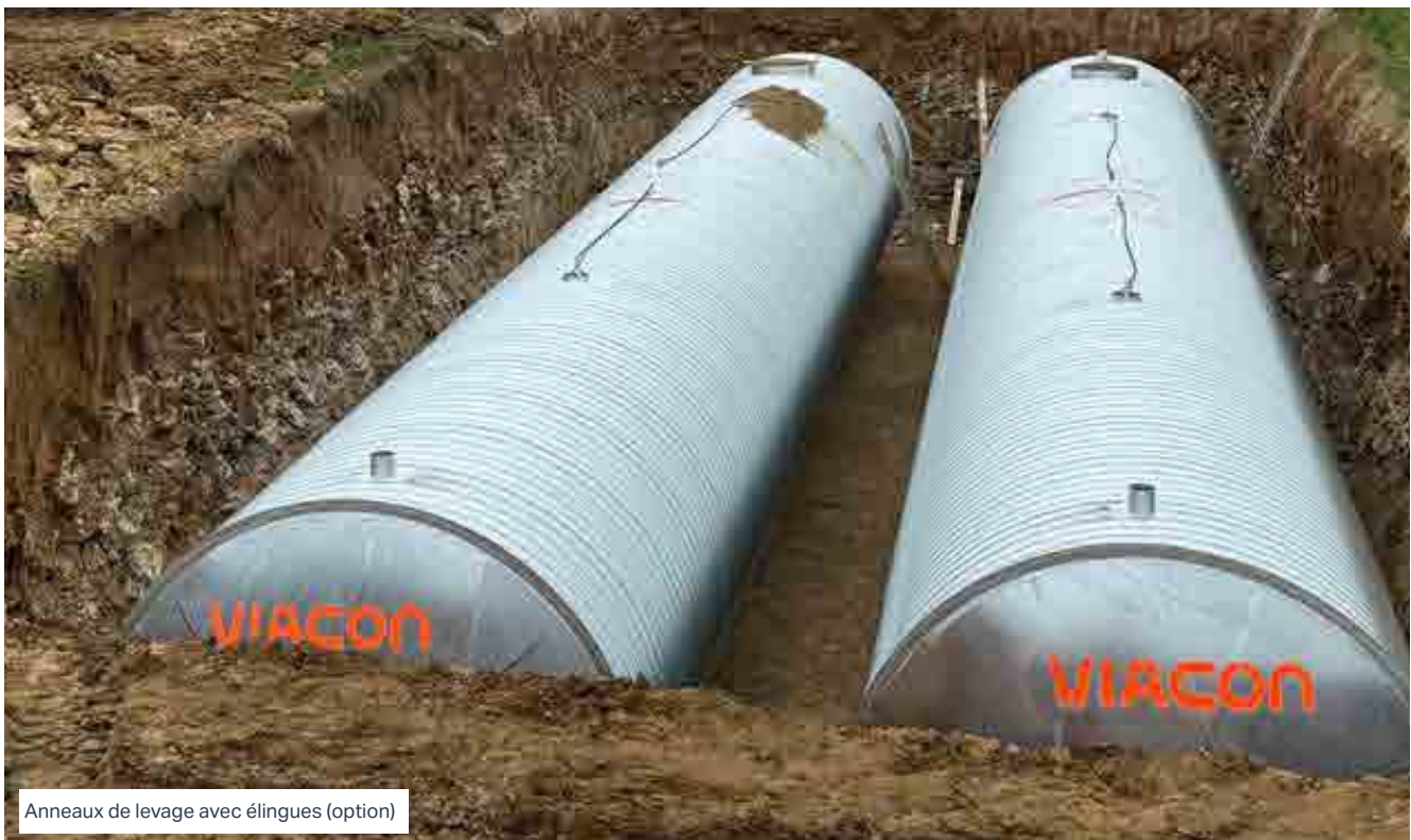
Cuves jumelées par pièces à brides
