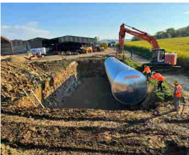
TuboFIRE® 120M 3 avec anneaux de levage
