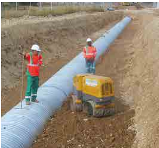
Lit de pose propre et stable
