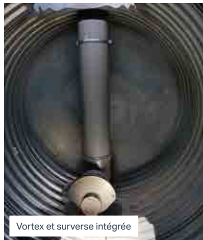
Vanne de confinement et vortex
