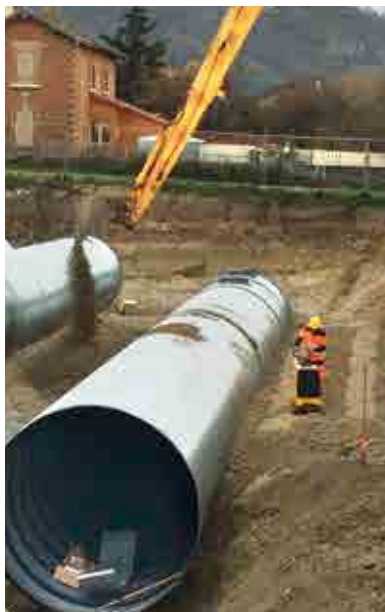
Compactage par couches symétriques de 30 cm
