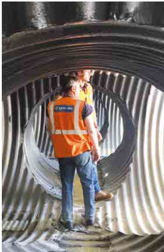
Visite d'un réservoir multilignes avec galerie transversale de communication hydraulique et technique
