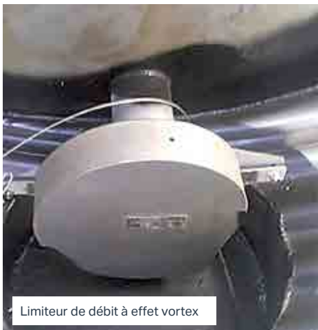
Vortex et surverse intégrée
