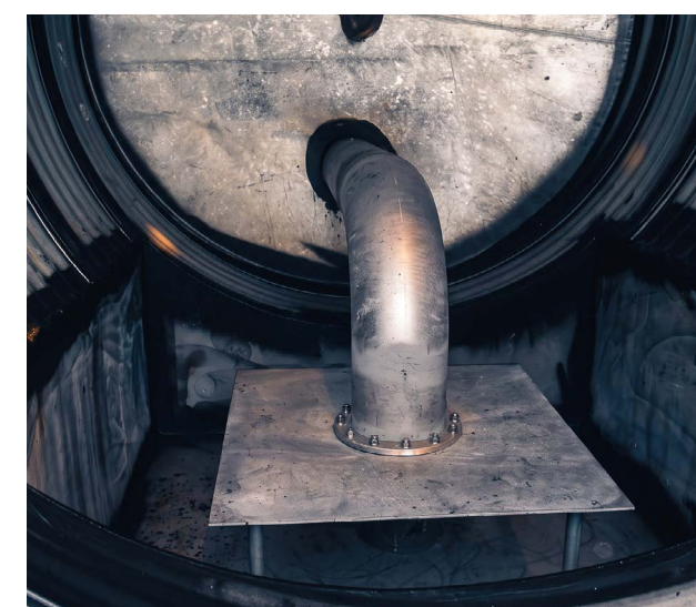
Aspiration anti-vortex dans caisson
