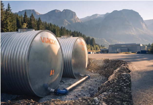
Cuves jumelées par pièces à brides*
